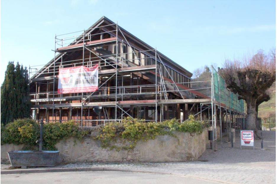
Das Dach an der Ostseite musste neu gedeckt werden, weil viele der Ziegel soweit geschädigt waren, dass die Gefahr bestand, dass Regen eindringt. Außerdem waren die Hölzer an den oberen Fenstern und unter der Dachkante durch Witterungseinflüsse gleichfalls stark geschädigt. Handlungsbedarf war also gegeben.
